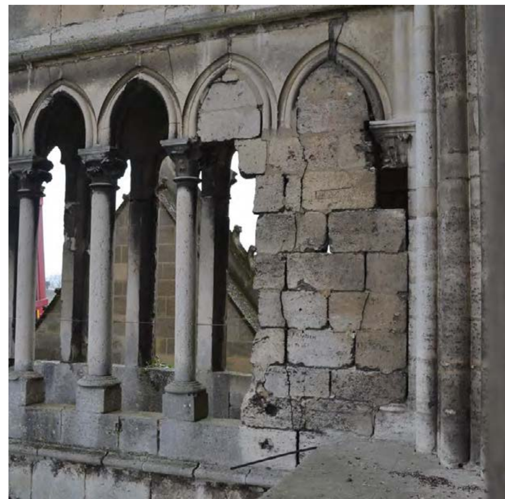
> Dégradation de maçonnerie, fissures
